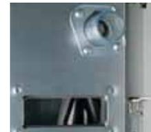
отверстие для проверки дренажа
